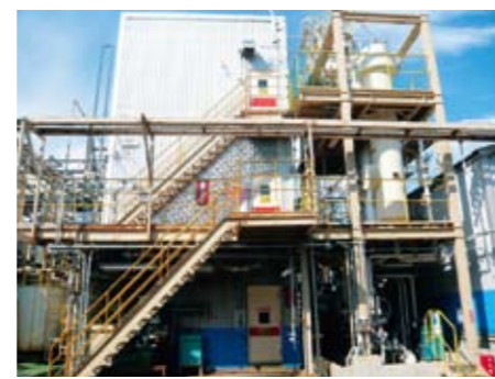
光氣生產設備外觀
